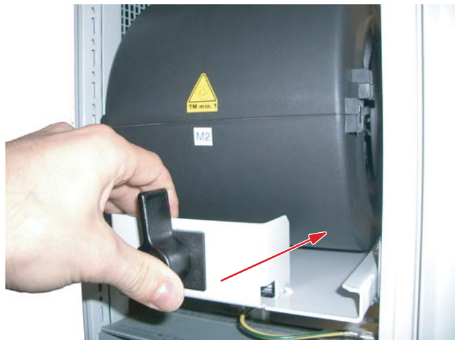
Fig. 30: Plugging in the fan module
